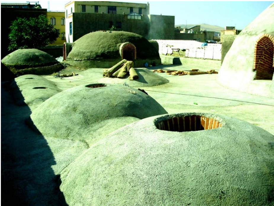
تصویر ۱۰. پوشش بیرونی گنبد‌های عرقچین بخش‌های دیگر حمام (آرشیو میراث فرهنگی ارومیه)
