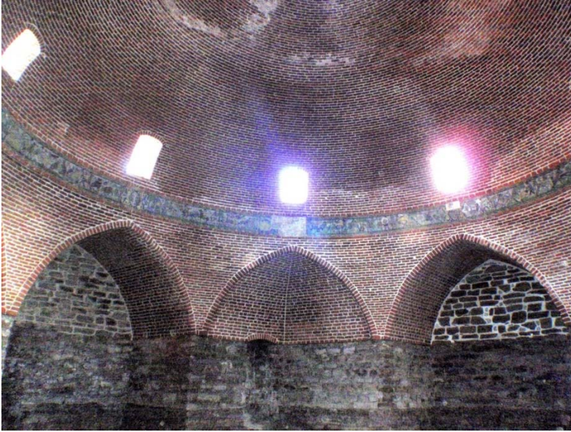
تصویر ۳. نمای داخلی سقف سربینه و تزئینات کاشی کاری ساقه گنبد (آرشیو میراث فرهنگی ارومیه)
