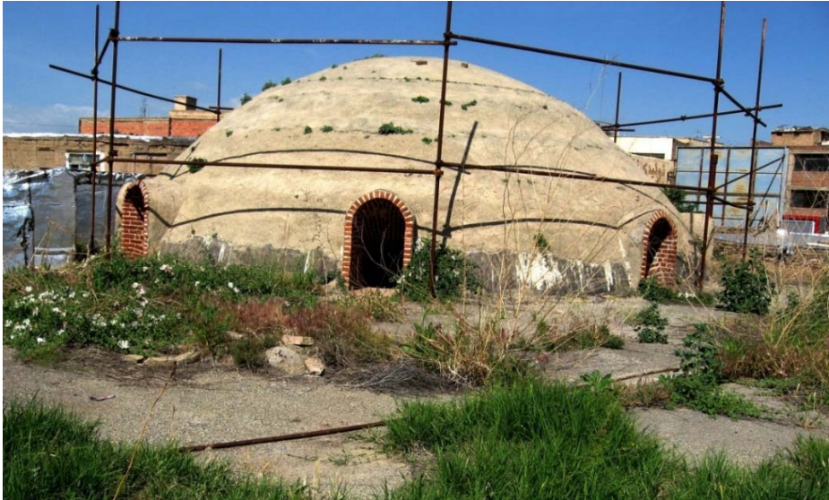
تصویر ۹. نمای بیرونی گنبد آجری بخش سریننه حمام (آرشیو میراث فرهنگی ارومیه)
