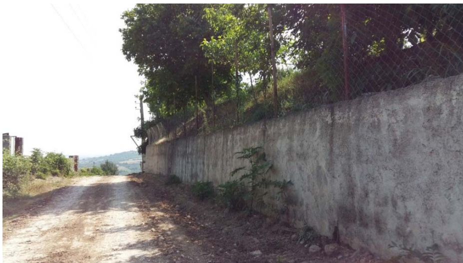
تصویر ۳. ضلع جنوبی دیواره‌ی خندق که توسط باغ‌دار دیوار گشته و درون آن جاده کشیده شده است
