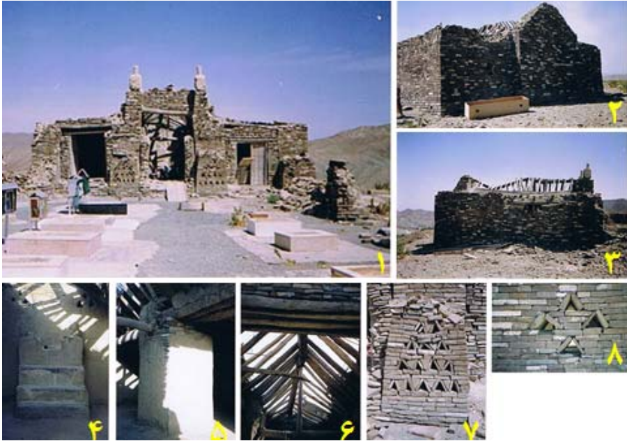
تصویر ۴. ۱: نمای کلی حسینیه-دید از جنوب غربی، ۲: نمای ضلع شمالی حسینیه، ۳: نمای ضلع شرقی، ۴: منبر، ۵: یکی از چهارستون درون حسینیه، ۶: نحوه اجرای سقف شیروانی شکل آن، ۷: محل روشن کردن شمع و عود در دو طرف ورودی، ۸: نمونه نورگیرها - همه تصاویر مربوط به پیش از بازسازی حسینیه هستند.
