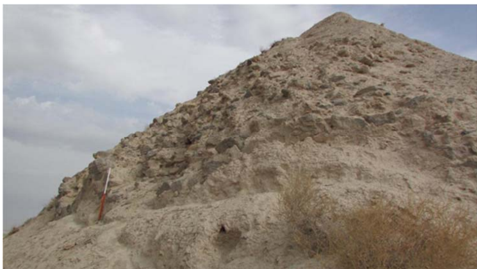
تصویر ۴. نمای جنوبی پی‌سازی برج جنوبی
