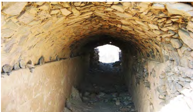
تصویر ۷. فضای داخلی یکی از تالارهای قسمت شمالی حیاط چهار ایوانه در بالاترین سطح قلعه - دید از شرق (نگارندگان، ۱۳۸۹)
